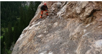
Kontrolle Felswand und Begleitung Felsräumung nach erfolgreicher Sprengung
