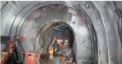
Bild 1: Ausführung von Rohrschirmbohrungen im Übergangsbereich Fels - Lockergestein
