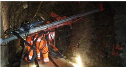
Bild 2: Durchführung von Gewölbesondierungen im Rahmen der Ausführung
