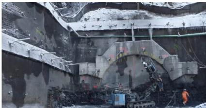
Die Baugrube für den Voreinschnitt am Nordportal des Tunnels Plattas erfordert eine Sicherung mit vorgespannten Ankern und Nägeln.
