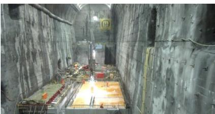
Vollständig ausgebrochene Maschinenkaverne während den ersten Betonarbeiten 2012.
