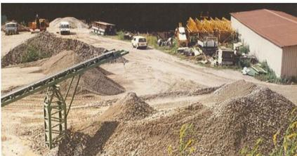
Die unbelasteten, steinigen Grobfraktionen werden vom restlichen Deponiematerial abgetrennt.
