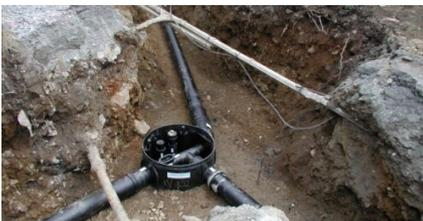
In der engeren Schutzzone wurden neue Abwasserrohre doppelwandig ausgeführt.
