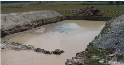
Schlammabsetzung während Pumpversuch.
