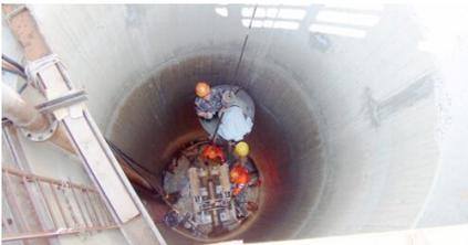
Brunnensenkschacht, Erstellung des horizontalen Filtergestänges.
