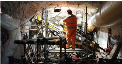
Ausführung von langen Bild 1: Kernbohrungen mit Standrohr und Preventerschutz durch eine wasserführende Störzone
