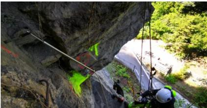
Kontrolle Felswand nach Felsräumung und Installation der Messüberwachung an der Grosskluft (Rissriegel und automatische Jointmetermessung).
