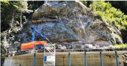
Ansicht Felswand während Bauarbeit für die Stützmassnahmen (rückverankerter Betonriegel)
